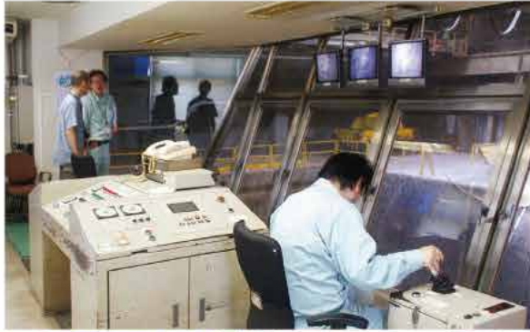
24 時間態勢でピット内のごみを焼却炉へ運ぶクレーンを操作する操作室
