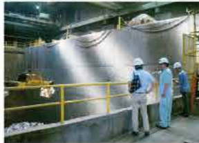
巨大なゴミピットを上からのぞく
