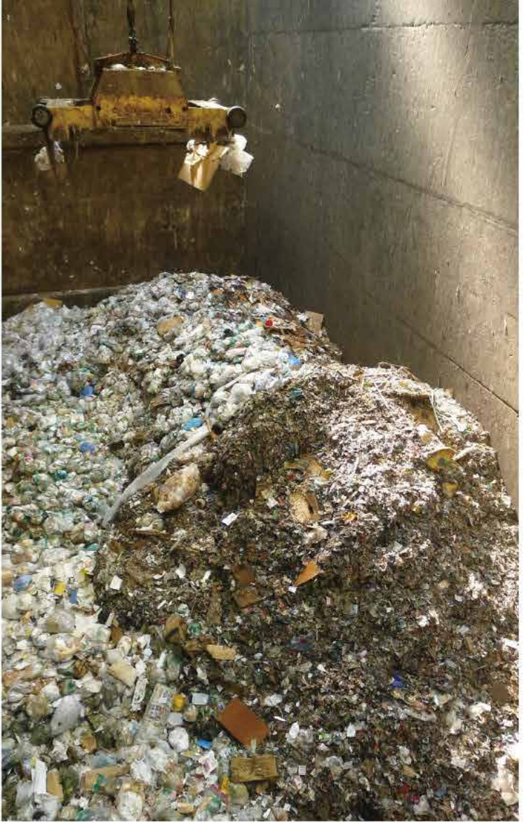
3,800tの可燃ごみを処理できる「リニアット」
